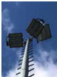
– die Flutlichtanlage auf LED-Leuchtkörper umgestellt. Dem Verein steht damit eine moderne, den heutigen Anforderungen genügende Flutlichtanlage zur Verfügung, die obendrein den Stromverbrauch (und damit die Stromkosten) wirkungsvoll um ca. 65 % senken wird.
